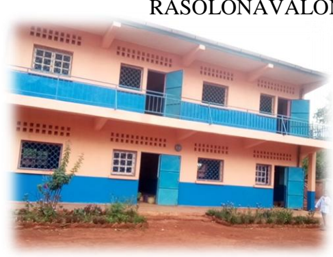
Bâtiment du collège rénové
